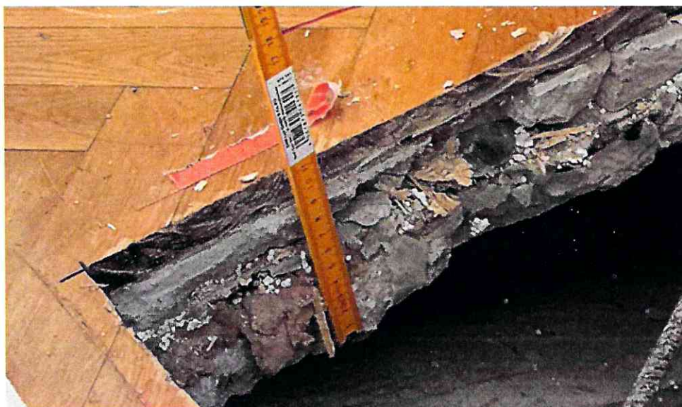
Fotografia 15: odkrywka nr 1 – parkiet ułożony bezpośrednio na wylewce.
