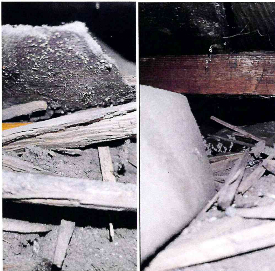
Fotografia 17: Fragmenty drewna i papy ujawnione w odkrywce nr 2 posadzki. Surowe drewno.
